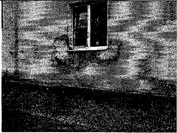
Фото 6, 7, 8, 9. Локальные разрушения защитного штукатурного слоя стены здания. Дефект эксплуатационного характера. Вызван промерзанием насыщенной влагой кладки и дальнейшим её разрушением, а также внешними механическими воздействиями (включая атмосферные осадки).
