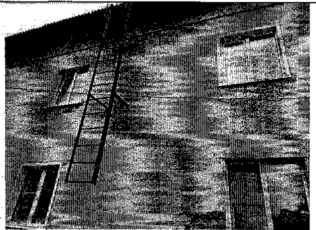
Фото 6, 7, 8, 9. Локальные разрушения защитного штукатурного слоя стены здания. Дефект эксплуатационного характера. Вызван промерзанием насыщенной влагой кладки и дальнейшим её разрушением, а также внешними механическими воздействиями (включая атмосферные осадки).
