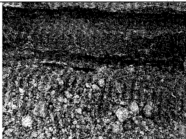
Фото 4, 5. Локальные участки трещин, следов растительности, проседания, неплотного примыкания отмостки к цоколю, что способствует замачиванию фундамента здания, а также подвального помещения и не соответствует требованиям п. 6.26 СП 82.13330.2016 «Благоустройство территорий». Локальные разрушения защитного штукатурного слоя стены, цоколя здания. Причина образования дефекта: следствие паводка, дефект эксплуатационного характера.
