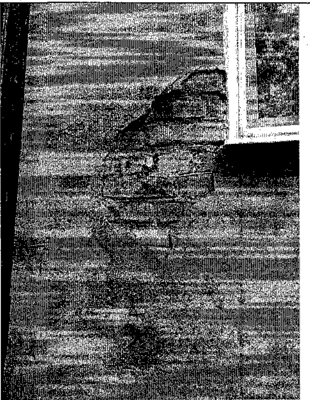
Фото 10, 11. Локальные разрушения защитного штукатурного слоя стены здания.
